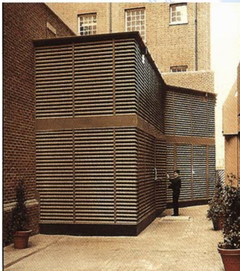
柴油发动机房的WLAC100钢制百叶窗
