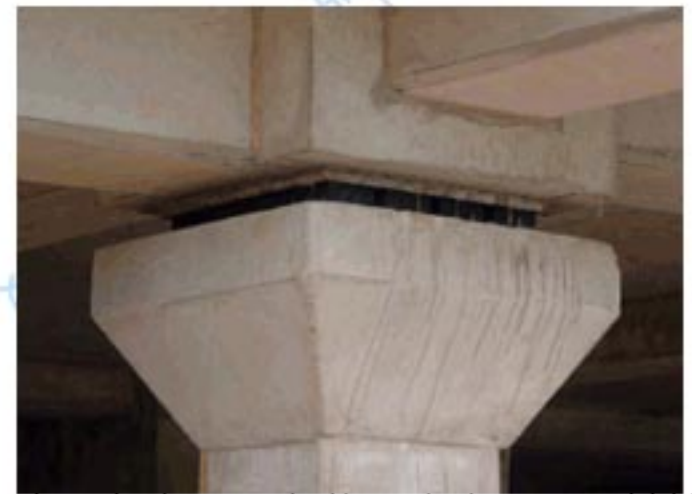
加固混凝土框架的隔音支承，10赫兹
