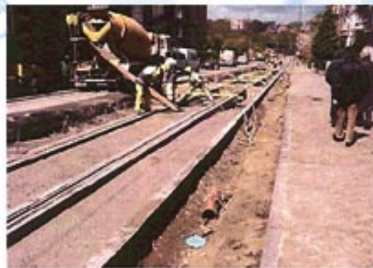
浇筑混凝土
