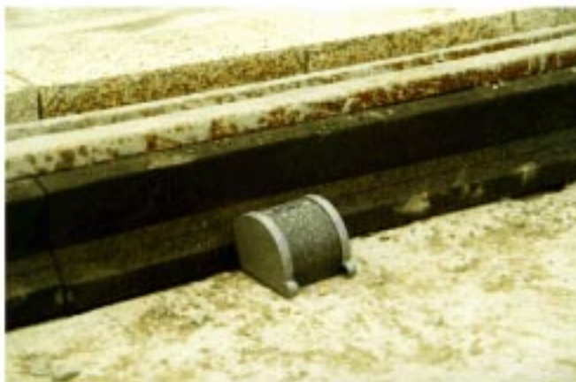
安装CDM-FLEXIWEB包壳及固定罩面 安装混凝土及道路涂层
