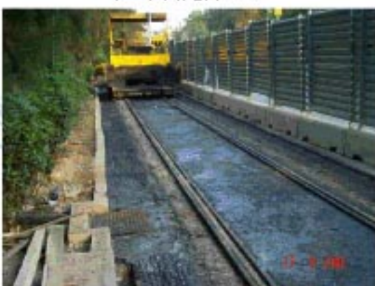
道路表面安装
