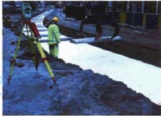
混凝土枕木安装
