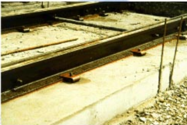
在轨道下安装CDM-ISO-SRS轨道条
