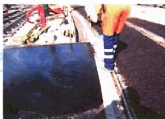
道路表面安装
