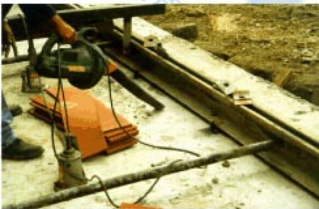
于固定装置下浇筑混凝土
