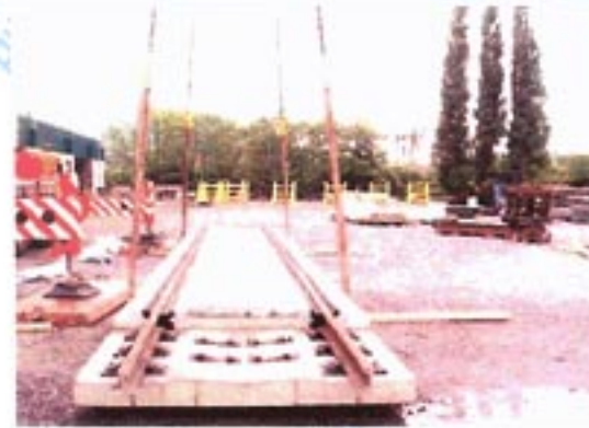
PREFARIAL-MODULIX抵达施工现场
