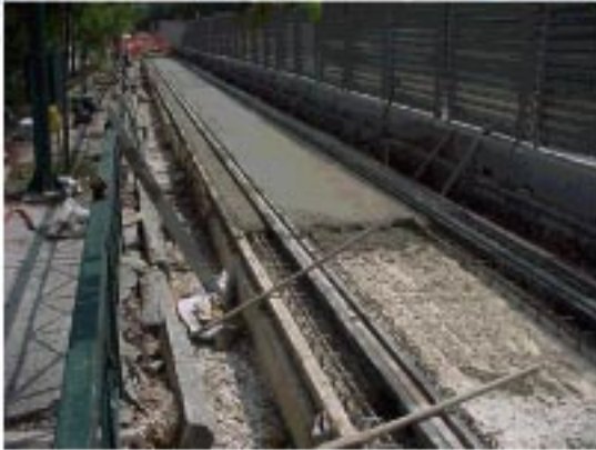
浇筑混凝土
