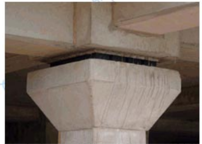
加固混凝土框架的隔音支承，10赫茲
