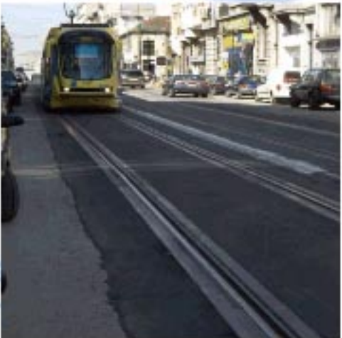
倒混凝土安裝軌道完成道路
