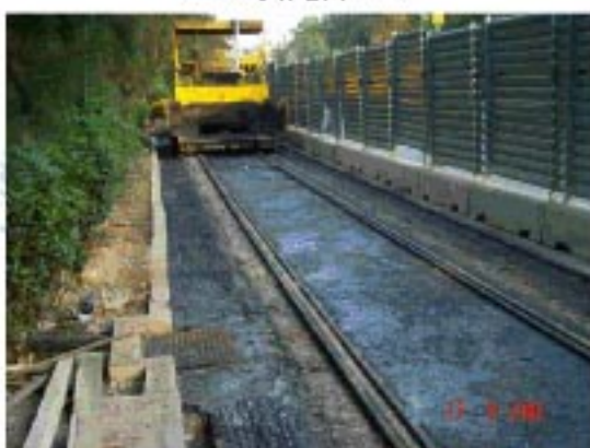
道路表面安裝
