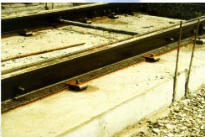
在軌道下安裝CDM-ISO-SRS軌道條
