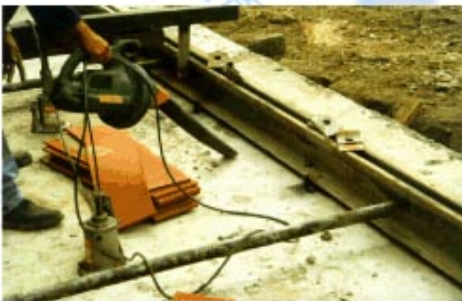
於固定裝置下澆鑄混凝土
