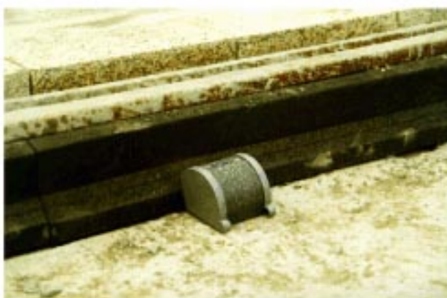
安裝CDM-FLEXIWEB包殼及固定罩面 安裝混凝土及道路塗層
