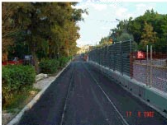
安裝完成，投入使用
