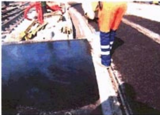
道路表面安裝
