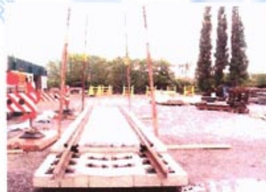
PREFARIAL-MODULIX抵達施工現場
