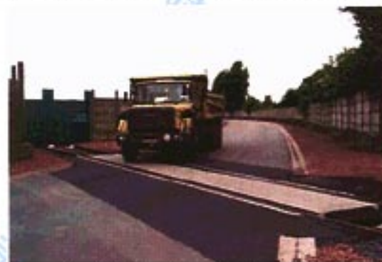
安裝完成，投入使用
