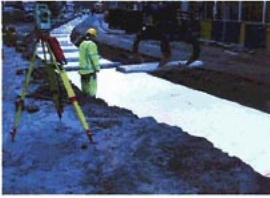
混凝土枕木安裝
